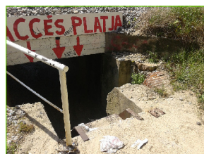
Substitució barana i sanejament murs
