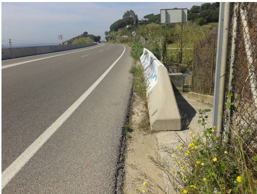
Accés rampa pas soterrat
