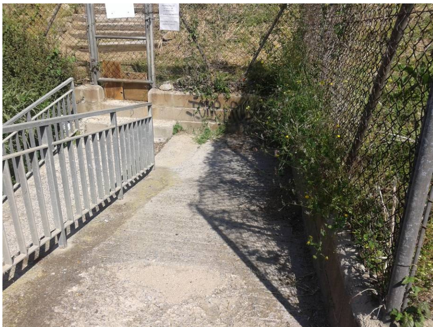
Rampa pas soterrat carretera Nacional II
