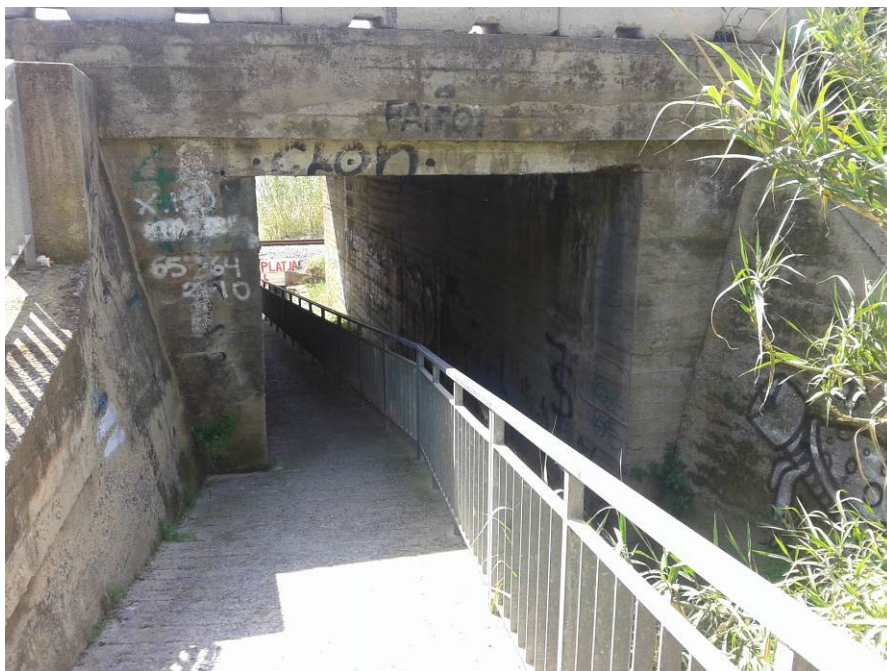
Rampa pas soterrat carretera Nacional II
