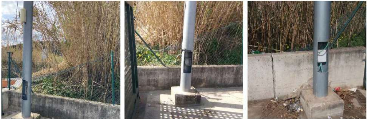
Fotografies de l'estat actual de les columnes d'enllumenat
