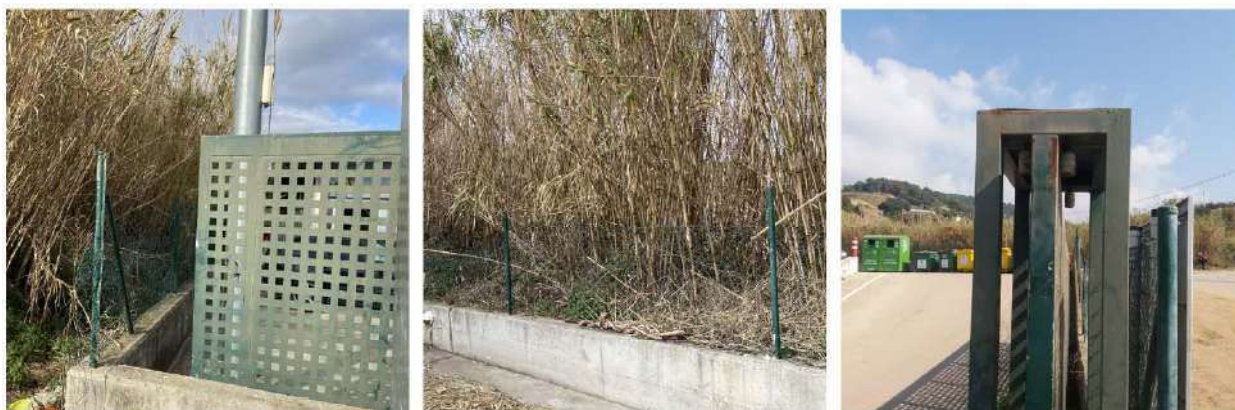
Fotografies de l'estat actual del cancell d'accés i clos de l'equipament
