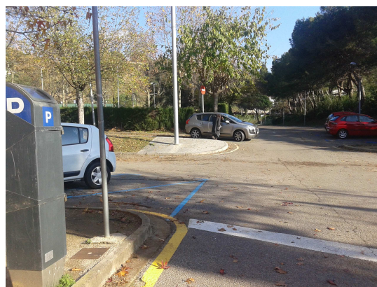
Vorera de panot a retallar per gir de bus
