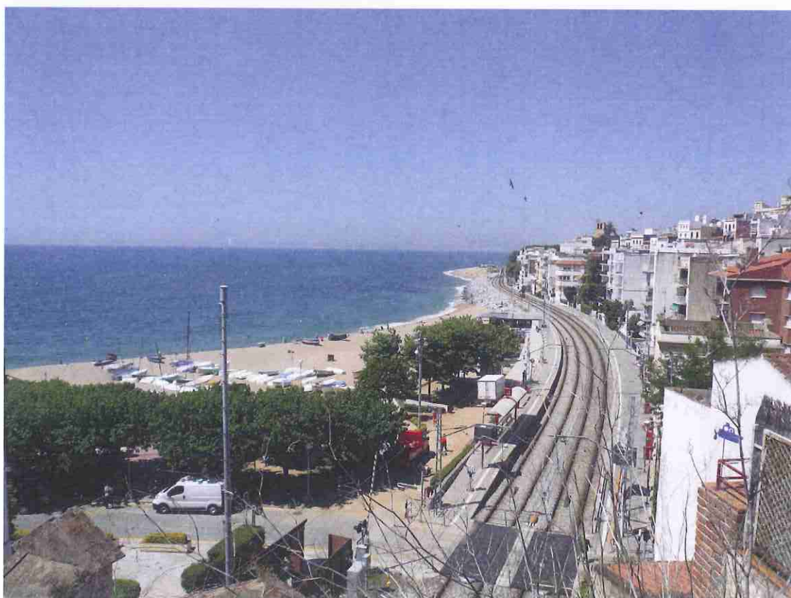
Zona de circulación de maquinaria para acceso al espigón
