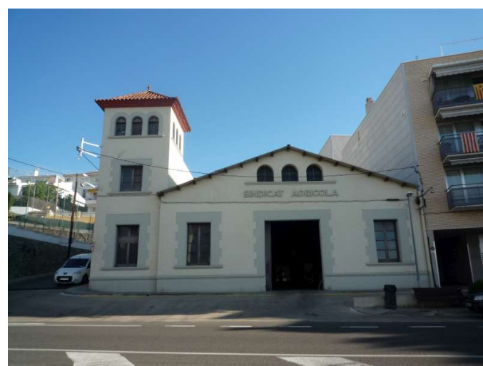
e1.2 Edifici del sindicat
