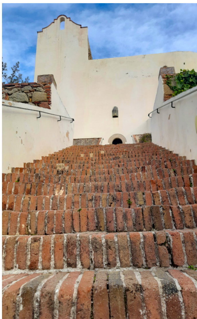
Els inconfusibles graons de Sant Pau, fets amb material de construcció de la línia ferroviària
