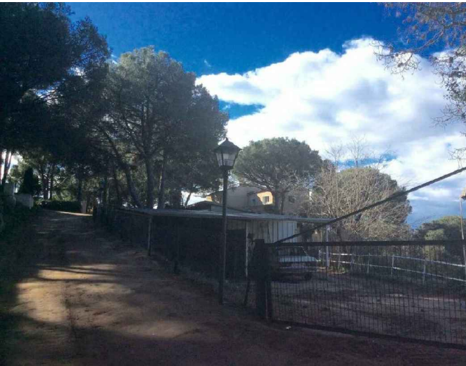
EDIFICACIÓ AUXILIAR I COBERT D'EINES
