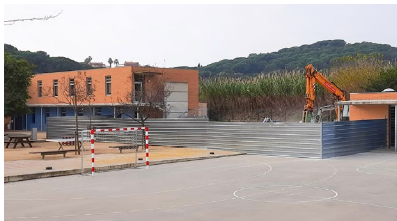
Obres de la primera fase d'ampliació de l'escola (any 2020)
