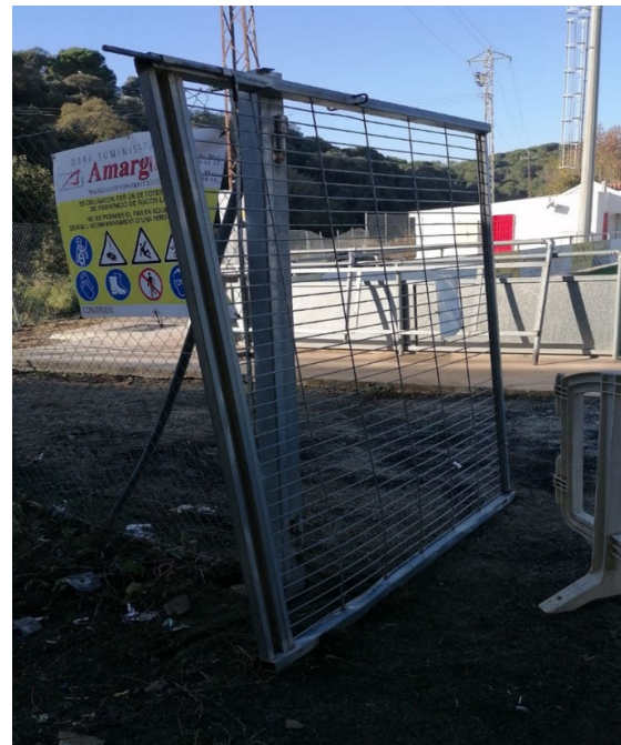
Portal d'entrada trencat que permet l'entrada de tothom a l'interior del camp de futbol
