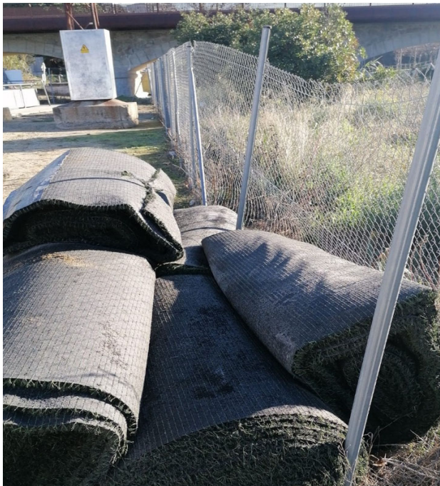
Bobines de gespa vella a retirar i tanca de simple torsió afectada per la caiguda de les bobines
