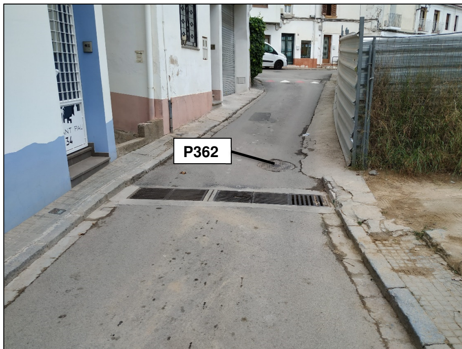
Figura 3: Inici del nou col·lector al pou p362. Carrer Sant Pau
