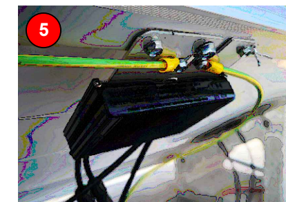
Unions de les diferents carcasses i estructures de la instal·lació fotovoltaica
