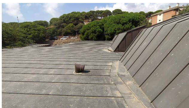
Fig. 3. Fotografies de la coberta
